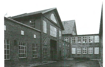
På Olaf Ryes Gade, nr. 7, ligger Kolding Firmacenter, tidligere "De Danske Mejeriers Maskinfabrik".
