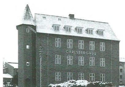
Arkitekt Ernst Petersens "Carlsberg-hus" fra 1931 i Domhusgade 2.
